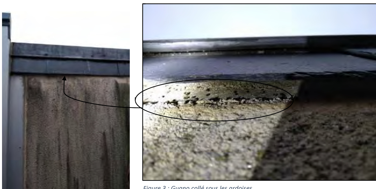
Figure 3 : Guano collé sous les ardoises
