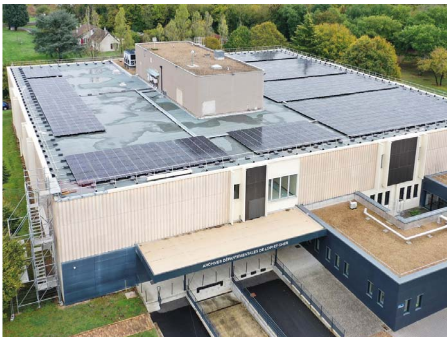
Panneaux photovoltaïques aux archives départementales de Vineuil
