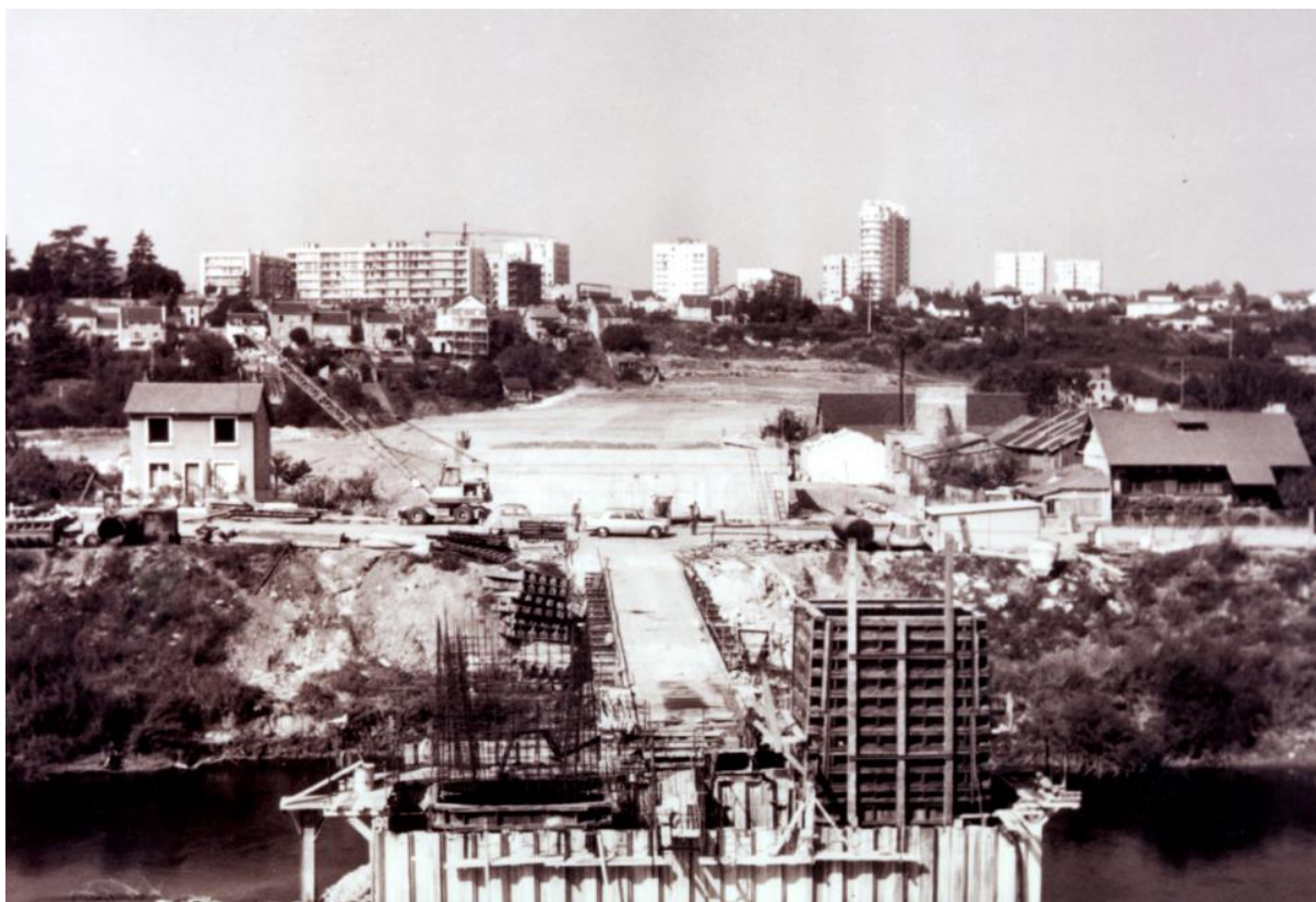
Construction du pont Charles-de-Gaulle à Blois, 1967-1970, AD41, 166 Fi 613.
